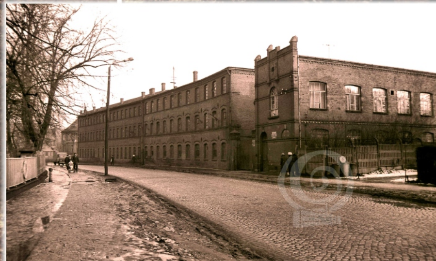
Pomorska Fabryka Gazomierzy, widok od strony ulicy, fot. Józef Ziółkowski
